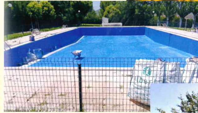
Reparación vaso piscina
